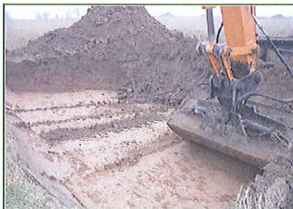
Dans le cadre d'une recherche d'un indice de cavité sur une superficie importante, ce type d'investigation peut être réalisé à l'aide d'un buteur muni d'une lame lisse. Le suivi consiste à identifier et interpréter la cohérence et l'homogénéité des formations en place.
